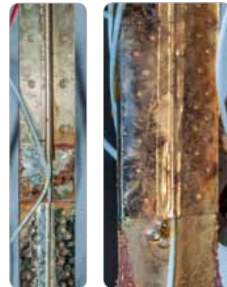
Obr. 3 Bodovo navárané FBG optické snímače (vľavo/dole – snímač deformácie, vpravo/hore – snímač teploty), krytie – polyuretánový lak; stav po dvoch mesiacoch v koróznom prostredí Obr. 4 Bodovo naváraný FBG optický snímač deformácie, krytie – epoxy živica; stav po dvoch mesiacoch v koróznom prostredí (korózia zvarov pod živickou)
